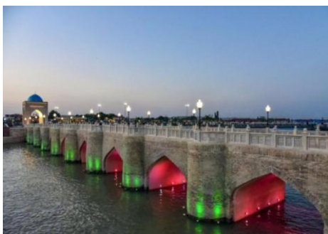
Рис. 1. 14-арочный мост через Кашкадарью
