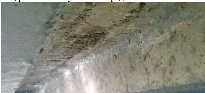
Фото2. Балки пролетного строения
